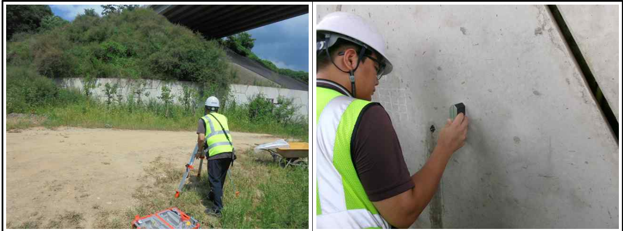
【사진 14.4.2】 측량작업 전경
