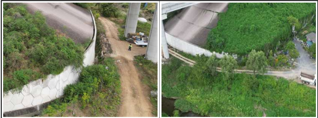
【사진 14.3.1】 지반, 기초부 전경
