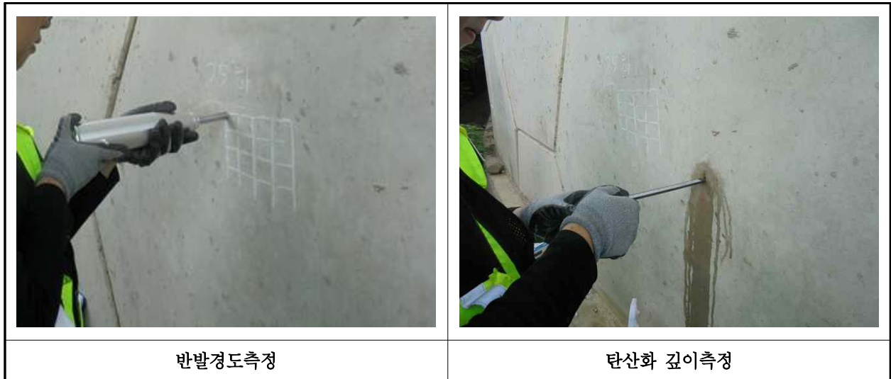
【사진 14.4.1】 재료시험 조사 전경
